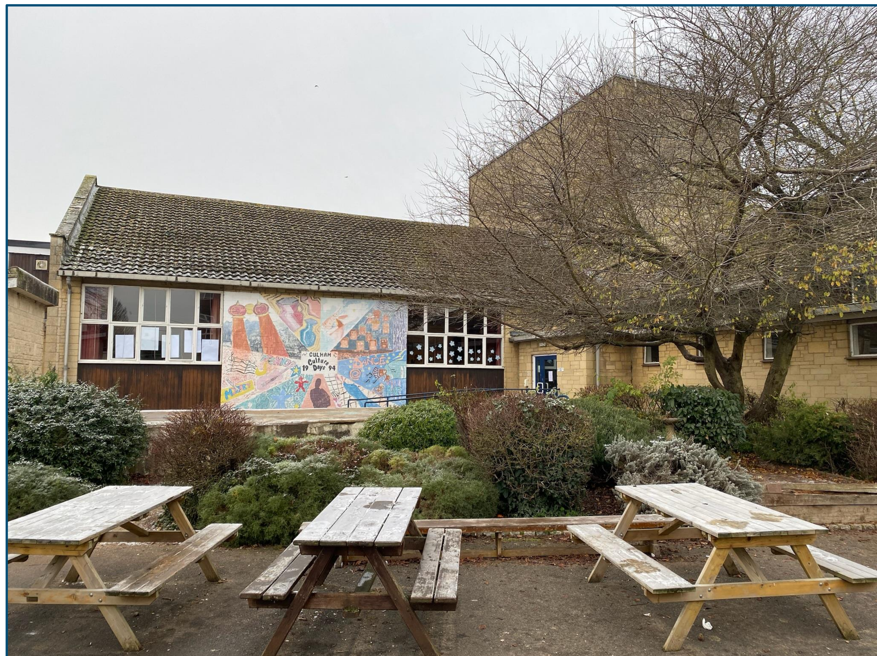
Ein Teil der Schulhofs – die Mensa befindet sich rechts im Bild,, geradeaus die Schuhmann Halle (Quelle: Eigene Aufnahme)
